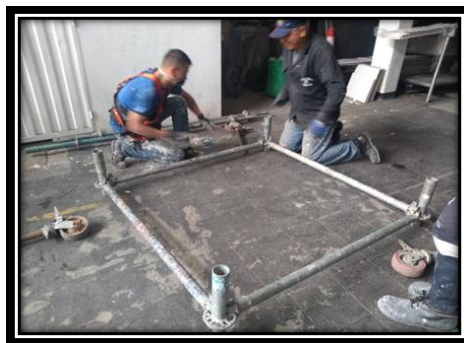
Ilustración 2. Instalación de base
