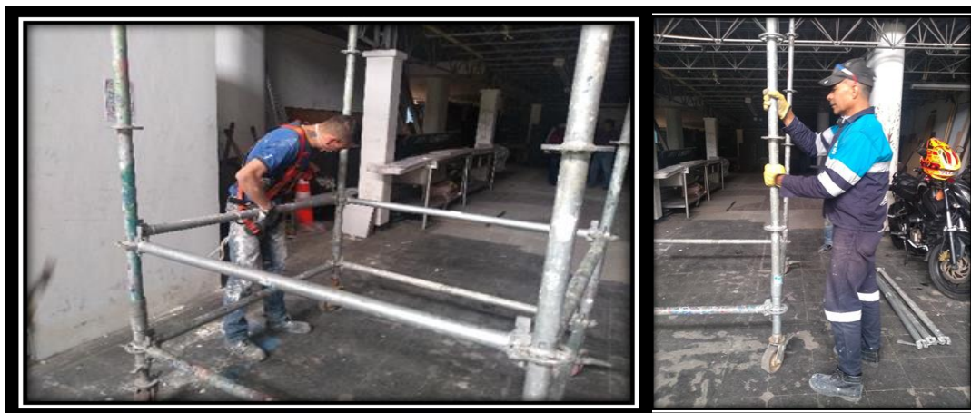
Ilustración 7. Ensamble del módulo base
