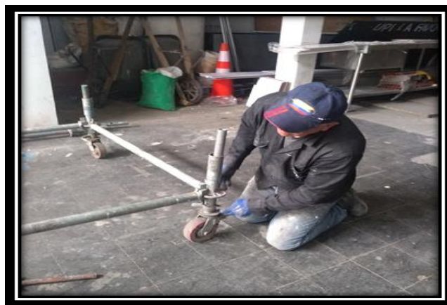
Ilustración 4. Chequeo de nivelación
