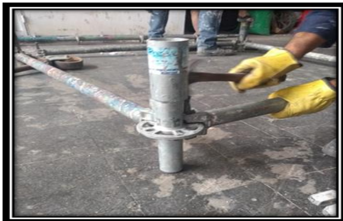
Ilustración 6. Aseguramiento de cuñas
